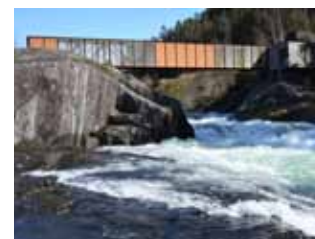
Høsebrua - moderne kulturminne.
